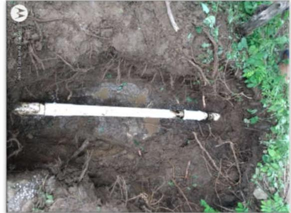
Reparación de un tubo de conducción de agua potable de la línea de puerto del tigre (frente a la casa de la Sra. Elvia), en la comunidad de Zuluapan, Oztoloapan, Estado de México.
