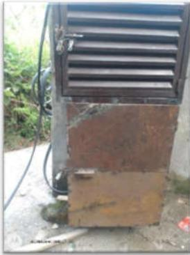
Se colocó una protección metálica para la seguridad del arrancador de la bomba de agua potable, que se encuentra en la Comunidad de Carranza, Otzoloapan, Estado de México.
