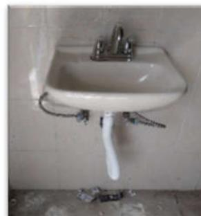
Colocación de un lavabo con todos sus accesorios, en los sanitarios del campo de fútbol de la Comunidad de Pinal del Marquezado, Otzoloapan, Estado de México.
